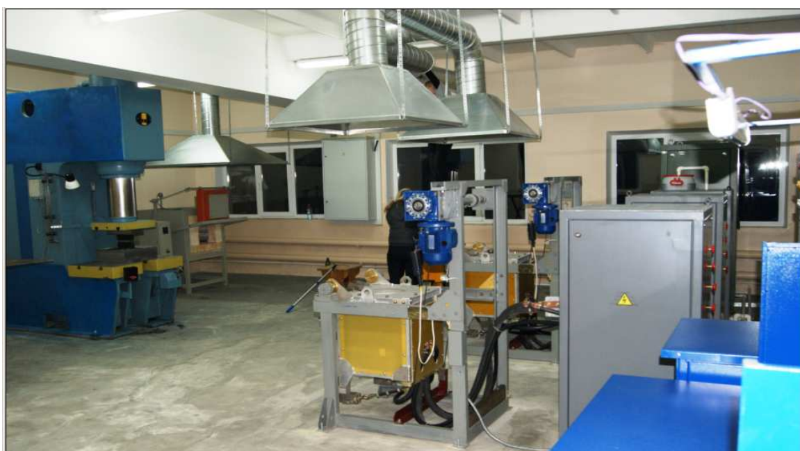
Рис. 2.15. Инжиниринговый центр «Термодеформ-МГТУ»
