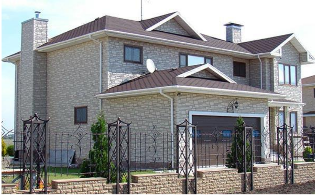
Рисунок 1.9 – Отделка фасада дома искусственным камнем (гипсовая плитка)
