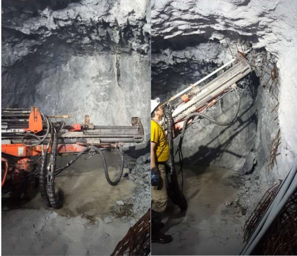
Рисунок 4.22. Стрела буровой кареты с демонтированными вкладышами люнет и установленным пуансоном (а) и процесс установки СЗА-армокаркас в сборе (б)
