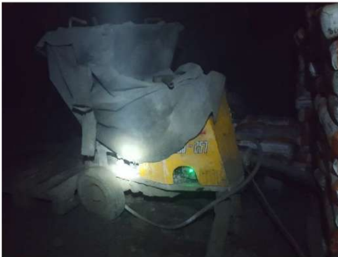
Рисунок 4.23. Процесс крепления стенки выработки в забое опытного участка установкой для нанесения торкрет-бетона Aliva-257
