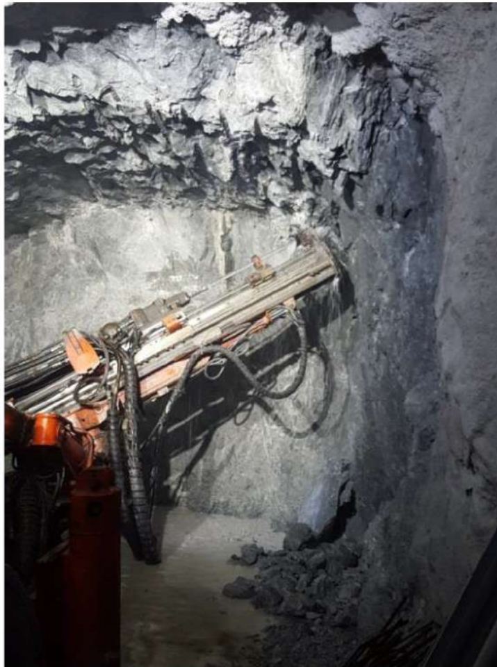
Рисунок 4.21. Процесс бурения шпуров под анкеры в стенке выработки ДШ-6 опытного участка
