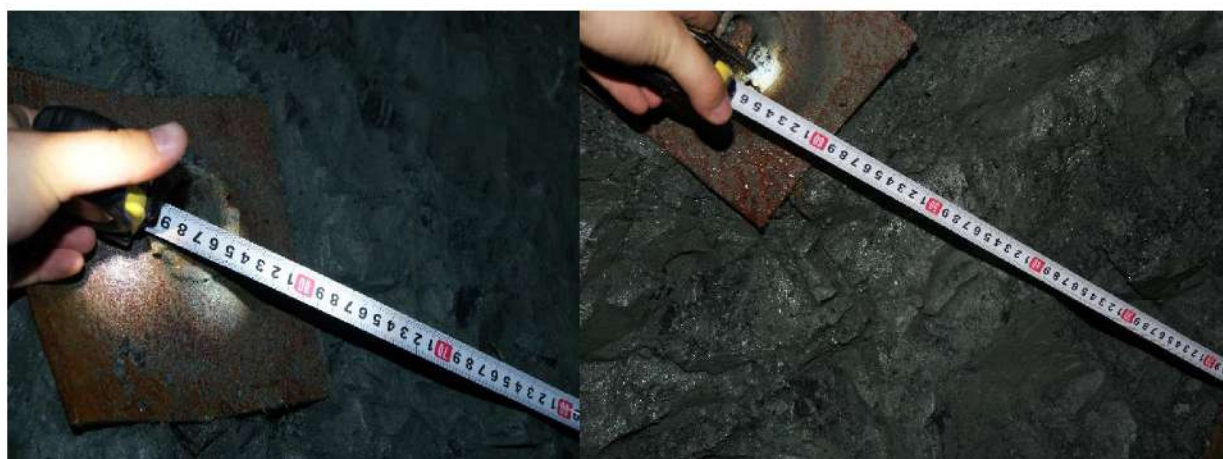
а) б) Рис. 3.11. Проверка крепления бортов выработки самозакрепляющейся анкерной крепью при сетке штангования: а) 0,7х0,7 м; б) 0,9х0,9 м
