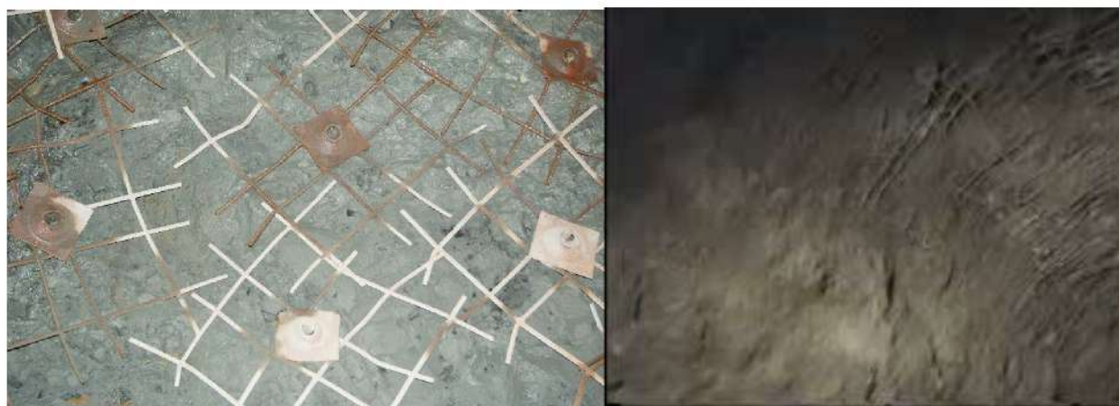
Рис. 3.12. Выработка, закрепленная усиленной комбинированной крепью: а) до нанесения слоя набрызг-бетона; б) после нанесения набрызг-бетона
