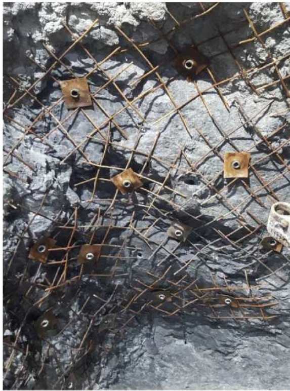
Рисунок 4.24. Фрагмент кровли выработки ДШ-6, закрепленный СЗА-армокрепь
