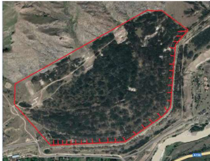
Рисунок 4. 2. Вид сверху хвостохранилища №2 Тырныаузской обогатительной фабрики с нанесением направления намыва хвостов при складировании
