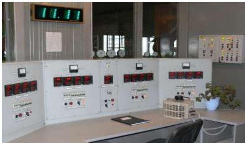
Рисунок 3.2 – Пульта управления реакторного отделения
