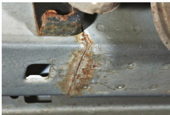
Рис. 1. Пример щелевой коррозии в стыковом соединении деталей машин
