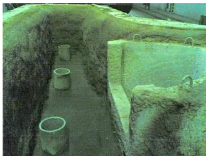
Рис. 1. Установка оборудования разливочного отверстия в ПК сортовой МНЛЗ
