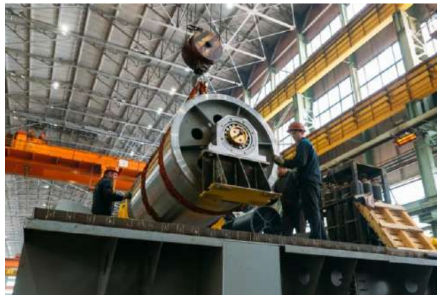
Рис. 6. Сборка мостового крана ООО «Судостроительный комплекс «Звезда»
