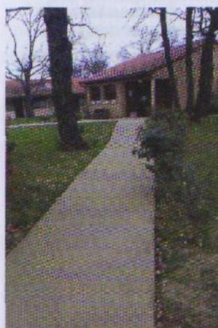
Grâce à sa palette de 9 teintes et la possibilité de créer des teintes sur-mesure, ce béton drainant offre des possibilités infinies dans la réalisation de formes grâce à l'insertion de pavés décoratifs. Il a été développé pour répondre à des sollicitations mécaniques en rapport à un usage piétonnier et un faible trafic de véhicules légers. La porosité ne fragilise pas la résistance du revêtement. De plus, DrainColor® assure une longue tenue de ses couleurs car le béton est teinté dans la masse.
