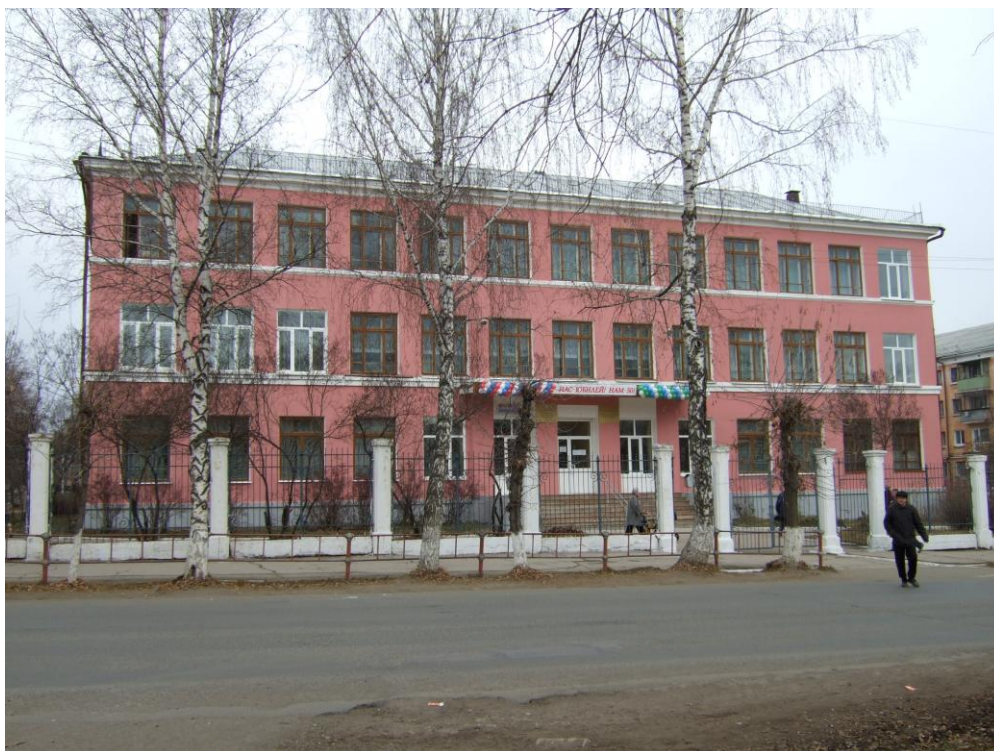
Фото 1. Здание филиала МГУ в г. Белорецке
