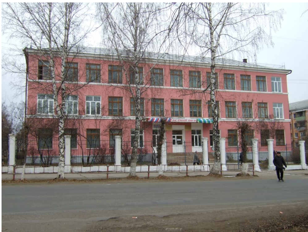
Фото 1. Здание филиала МГУ в г. Белоречке
