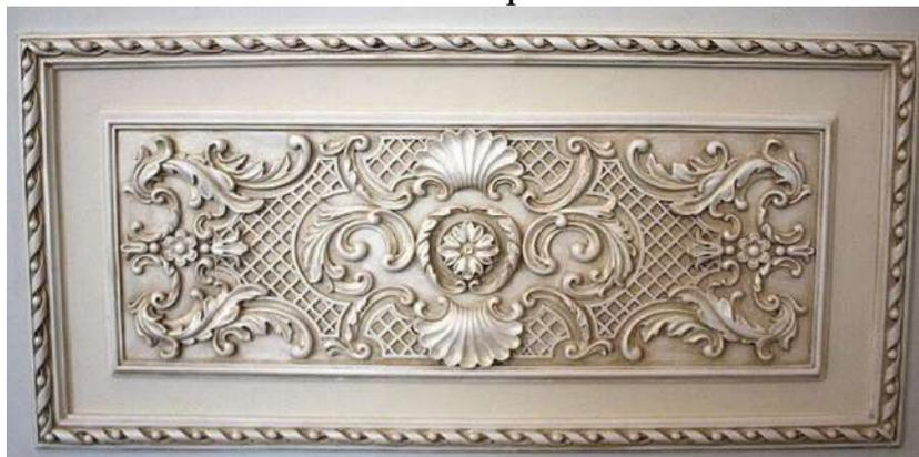
Рисунок 6. Рельеф из полиуретана
