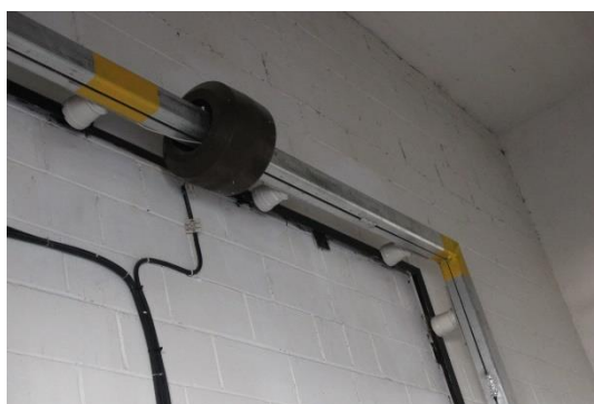
Рис 36 – Трансформатор тока
