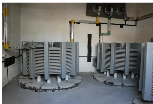
Рис 35 – Токоограничивающий реактор
