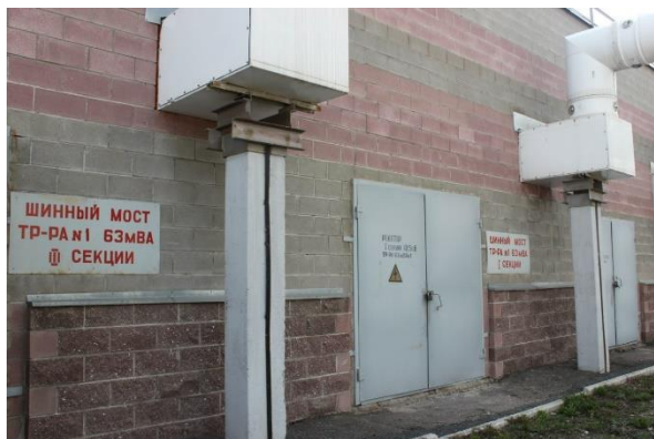
Рис 34 – Шинный мост
