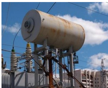
Рис 17 - Расширительный масляный бак
