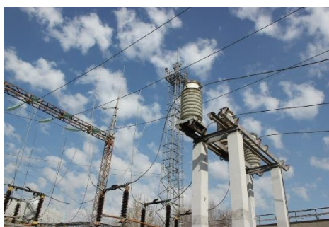
Рис 27 – Элегазовые выключатели
