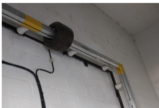
Рис 36 – Трансформатор тока
