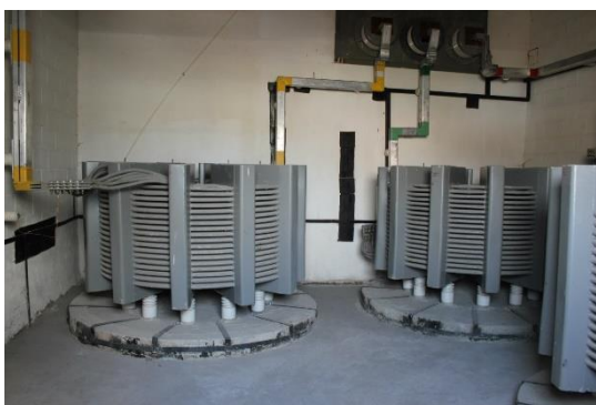
Рис 35 – Токоограничивающий реактор
