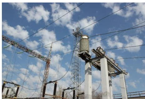
Рис 27 – Элегазовые выключатели
