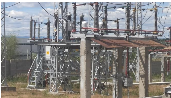
Рис 40 – Трансформаторы напряжения
