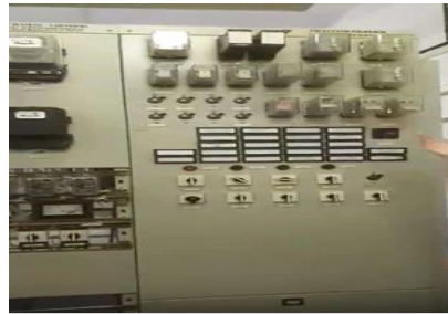
Рис 22 – Релейная защита
