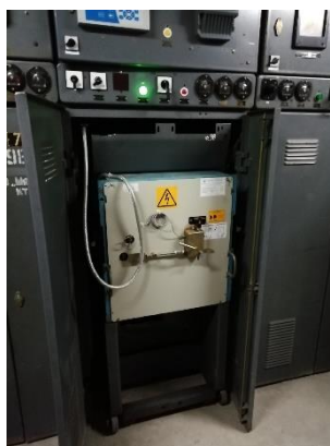
Рис 42 – Выключатель масляный
