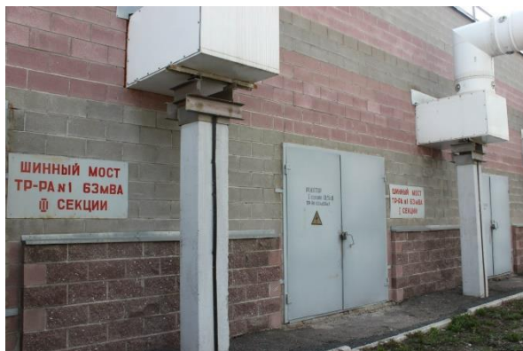
Рис 34 – Шинный мост
