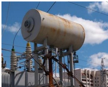
Рис 17 - Расширительный масляный бак
