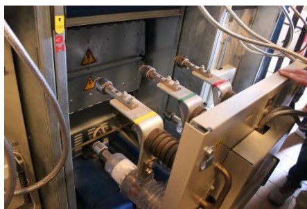
Рис №37 – вакуумный выключатель
