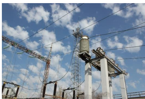
Рис 27 – Элегазовые выключатели
