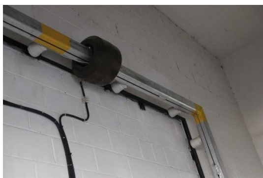
Рис 36 – Трансформатор тока
