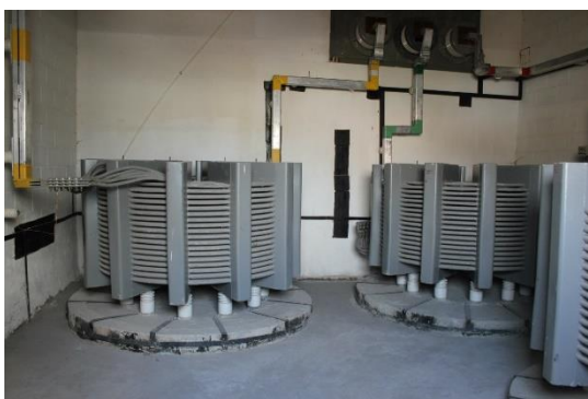
Рис 35 – Токоограничивающий реактор
