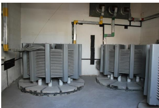
Рис 35 – Токоограничивающий реактор
