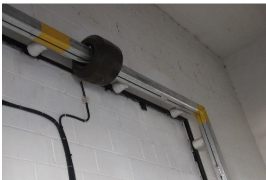
Рис 36 – Трансформатор тока
