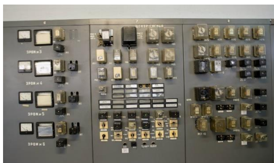
Рис 4- Панель сигнализации
