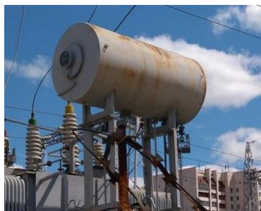
Рис 17 - Расширительный масляный бак
