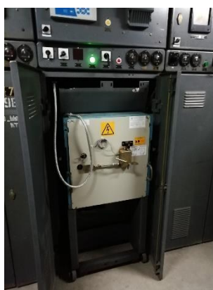
Рис 42 – Выключатель масляный
