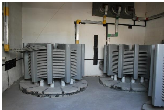
Рис 35 – Токоограничивающий реактор
