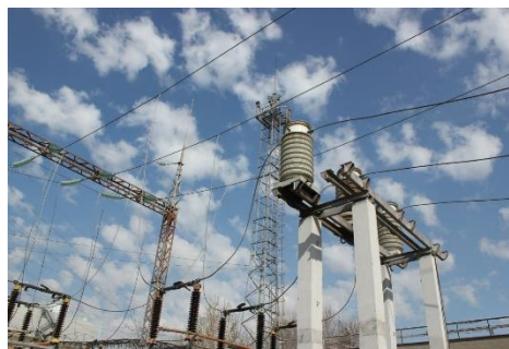
Рис 27 – Элегазовые выключатели
