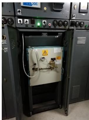
Рис 42 – Выключатель масляный
