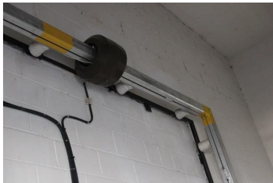
Рис 36 – Трансформатор тока
