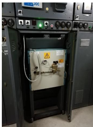
Рис 42 – Выключатель масляный
