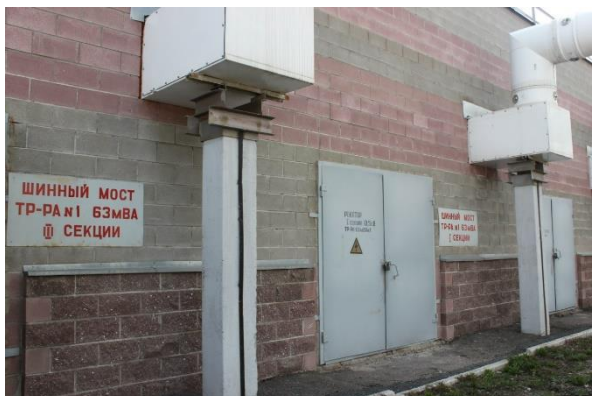
Рис 34 – Шинный мост
