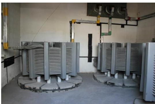
Рис 35 – Токоограничивающий реактор
