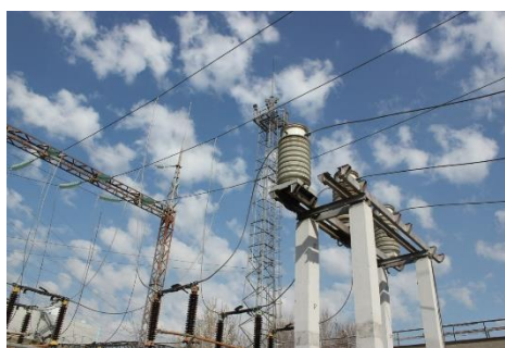
Рис 27 – Элегазовые выключатели
