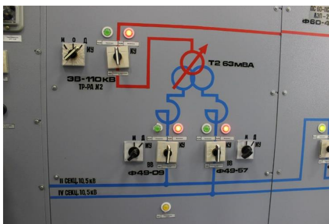
Рис 31 – Мнемосхема
