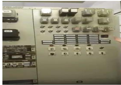
Рис 22 – Релейная защита
