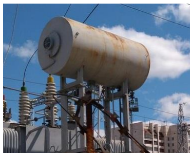
Рис 17 - Расширительный масляный бак
