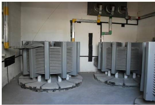
Рис 35 – Токоограничивающий реактор
