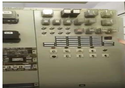
Рис 22 – Релейная защита
