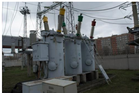
Рис 16 Масляный выключатель
