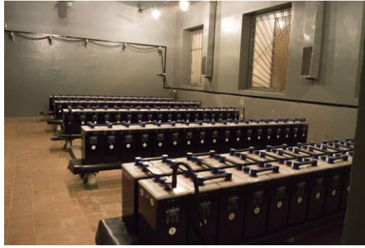
Рис 11 – Аккумуляторные батареи
