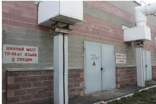
Рис 34 – Шинный мост
