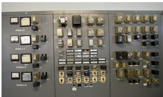
Рис 4- Панель сигнализации
