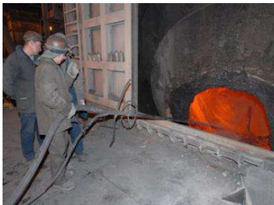
Рис. 4 Ремонт сталевыпускного отверстия (заполнение зазоров)
