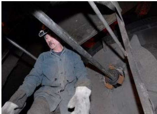
Рис. 3 Ремонт сталевыпускного отверстия (расклинивание периклазовым кирпичем)
