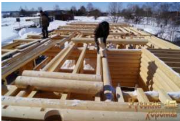
Рисунок Укладка бревен
