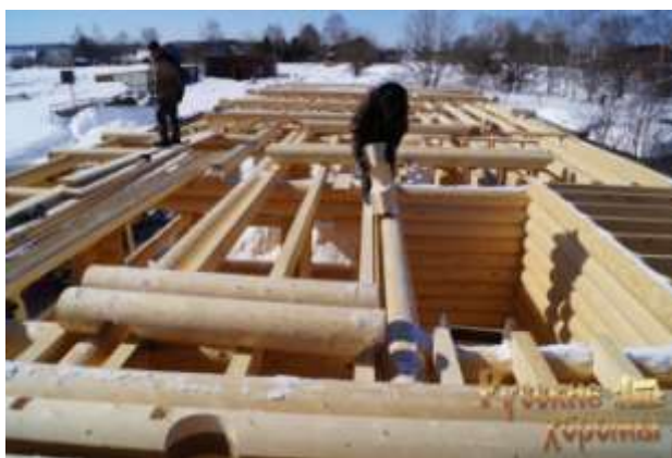
Рисунок Укладка бревен
