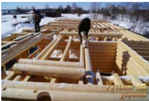
Рисунок Укладка бревен
