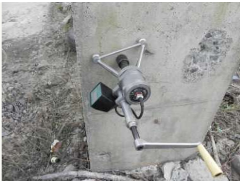
Предварительное обследование зданий и сооружений
