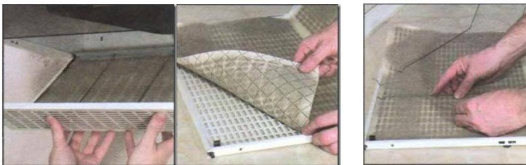
Рис.3 Замена жироулавливающего фильтра
