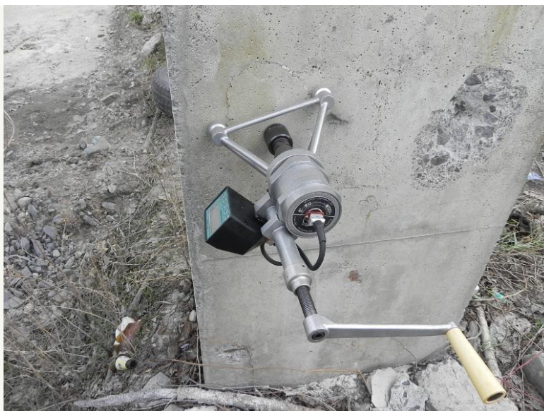
Предварительное обследование зданий и сооружений
