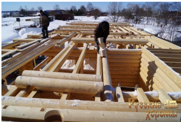
Рисунок Укладка бревен
