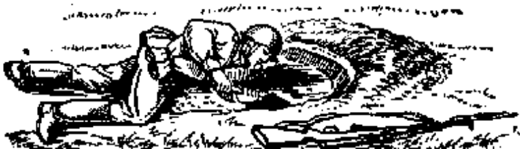
Рис. 6 Отрывка одиночного окопа для стрельбы лежа секторе обстрела высота бруствера уменьшается до 30 см, образуя выемку с пологими скатами - открытую бойницу.
