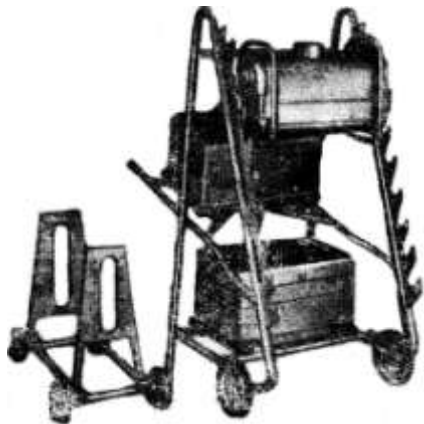
Рис. 2.3. Рентгеновский аппарат РУП-120-5-1
