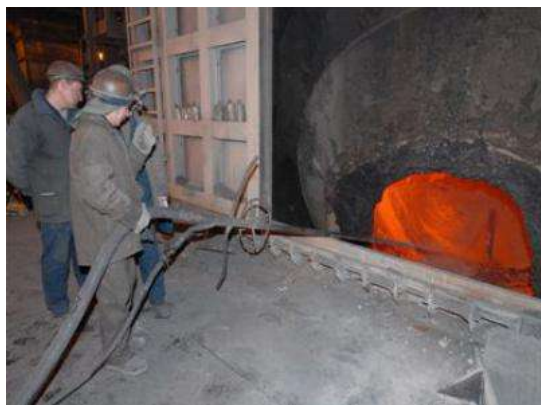
Рис. 4 Ремонт сталевыпускного отверстия (заполнение зазоров)
