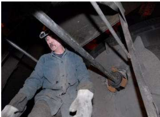
Рис. 3 Ремонт сталевыпускного отверстия (расклинивание периклазовым кирпичем)
