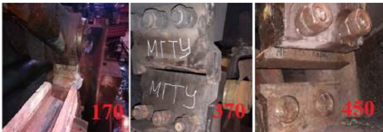
Рис. 2.62. Монтаж и эксплуатация отрезных ножей горячей резки №1 для станов 170, 370 и 450 ПАО «ММК»
