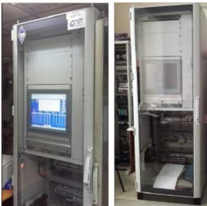
Рис. 1.21. Промышленный образец системы управления электрическим режимом с нелинейным адаптивным П-регулятором импеданса
