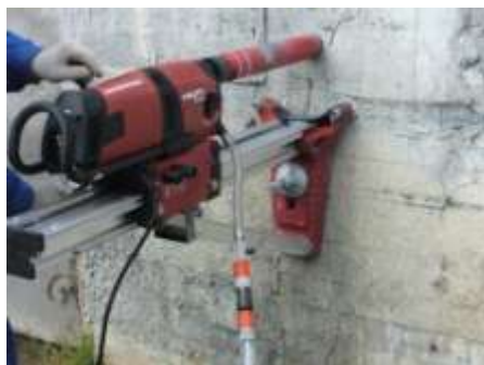
Рис. 1. Высверливание керна из бетонной монолитной конструкции
