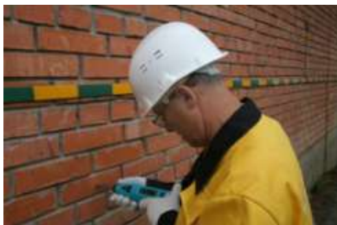
Рис.1. Измерение прочности кирпичной кладки прибором неразрушающего контроля «Silver Schmidt»
