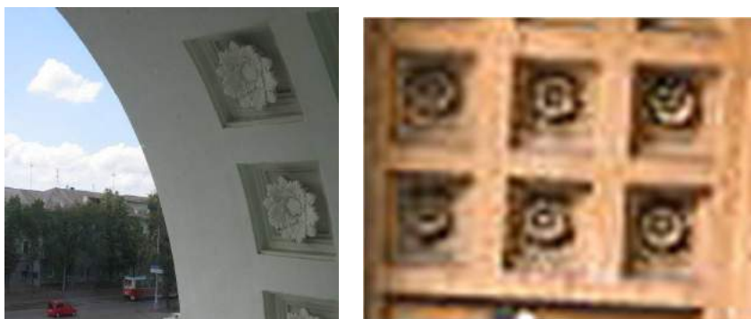
Рис. 26. Кессоны: г. Магнитогорск, г. Челябинск
