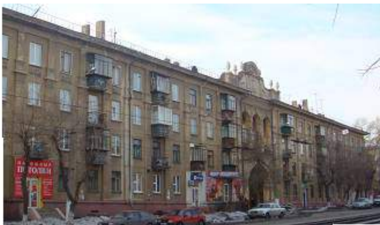
Рис.1. Первые крупнопанельные жилые дома в г. Магнитогорске 1951 - 1954 годы.
