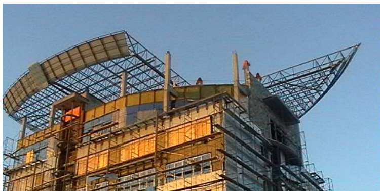
Рис. 5. Структурная конструкция в период монтажа
