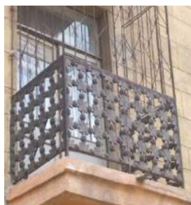
Рис. 34. Чугунное литье, ограждение балкона, пр. Metallургов, г. Магнитогорск
