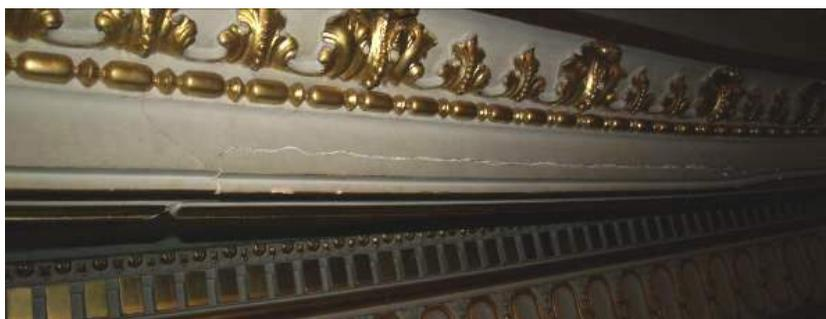
Рисунок 19. Трещина в декоративной штукатурке
