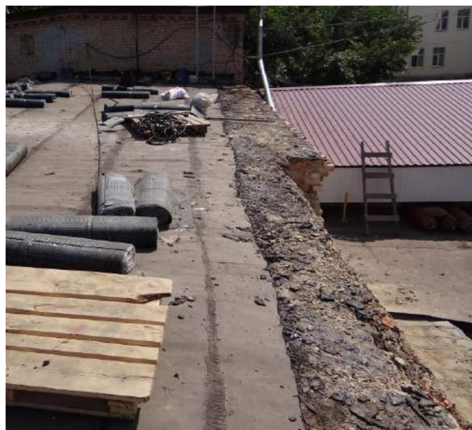
Рис. 4. Фрагмент кровельного покрытия одноэтажного здания
