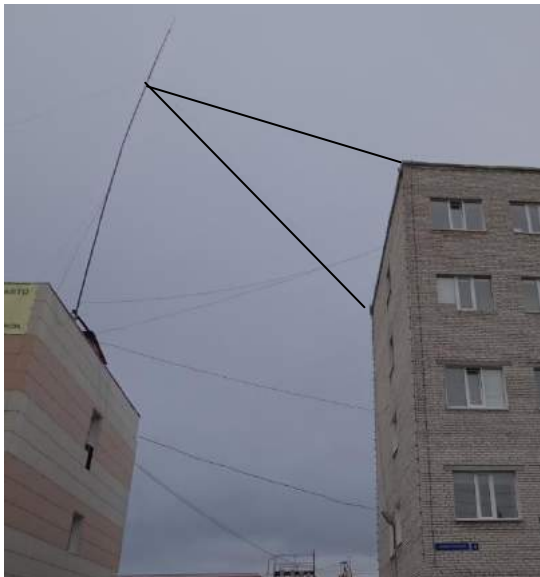
Рис. 5. Крепление оттяжек антенны к парапету административного здания
