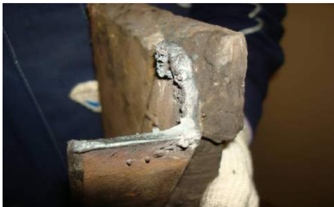
Рис. 3 – Кромки уголка подвески площадки крановых колес после обрушения
