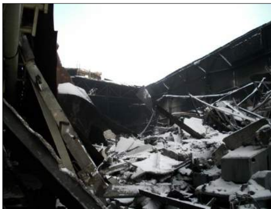
Фото 4. Обрушение покрытия травильного отделения здания
