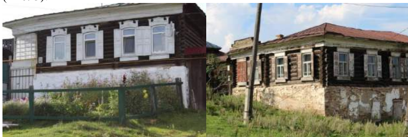
Рис. 3. Типы полукаменных домов: «пятистенок», сложный дом «пятистенок» «со связью». Тирлянь
