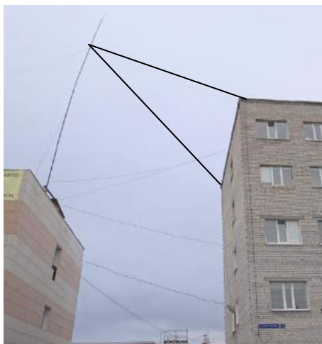
Рис. 3. Крепление оттяжек антенны к парапету административного здания
