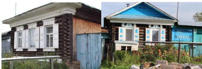
Рис. 1. Изба «клетью» на три окна без подклети, на два окна с подклетью. Тирлян
