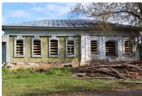
Рис. 6. Окна деревянной и каменной части дома
