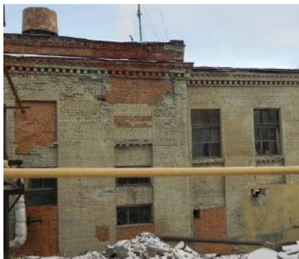
Рис. 6. Здание котельного отделения после проведения ремонтно-восстановительных работ
