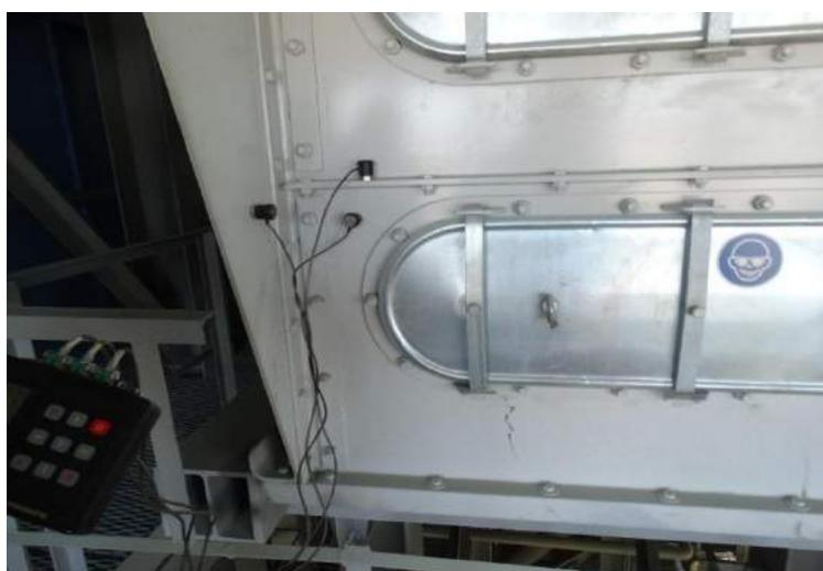
Рис. 3. Размещение вибродатчиков на грохоте
