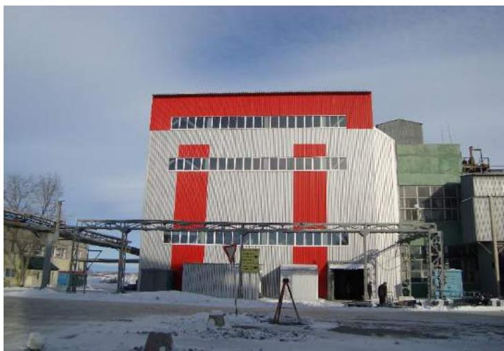
Рис. 1. Цех по производству гранул с металлическим каркасом и АБК с железобетонным каркасом
