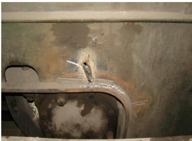
Рис. 1. Трещины в сварных швах концевой балки мостового крана грузоподъемностью  $Q=16+16$  т.
