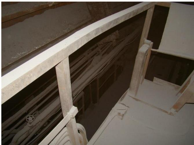
Рис. 7. Отсутствие среднего элемента перильного ограждения
