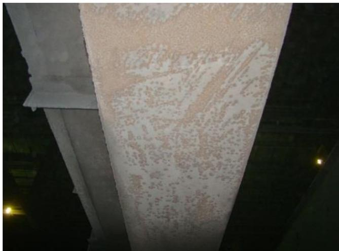
Рис. 6. Разрушение лакокрасочного покрытия и поверхностная коррозия нижнего пояса главной балки
