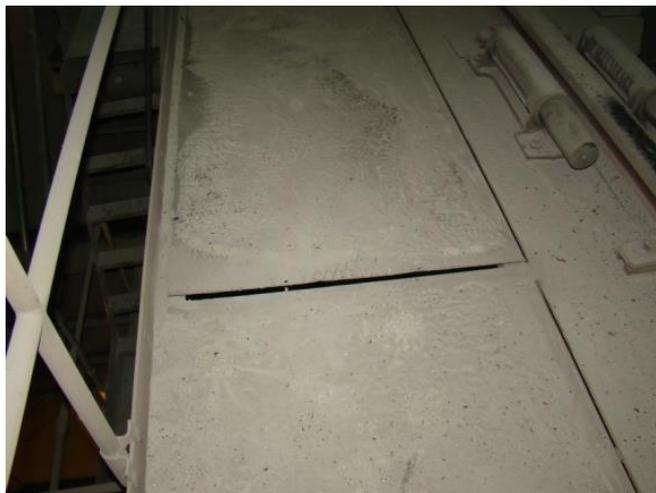
Рис. 10. Разрушение сварного шва настила площадки обслуживания
