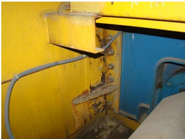
Рис. 2. Трещины в узле сопряжения главной и концевой балок мостового крана грузоподъемностью Q=50/10 т.
