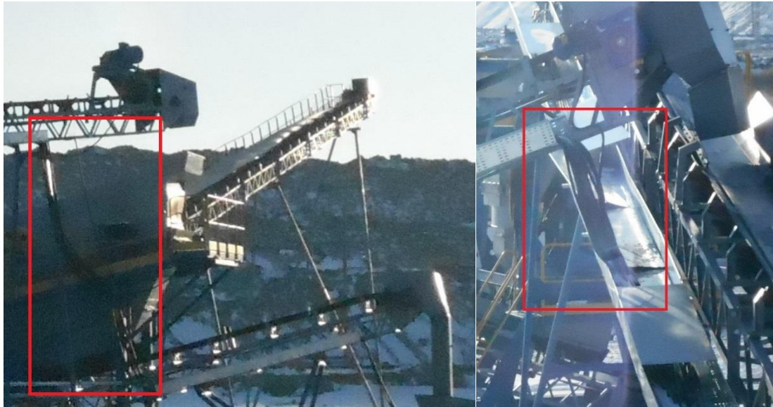
Рис.2. Открытые переходы на кабельной трассе
