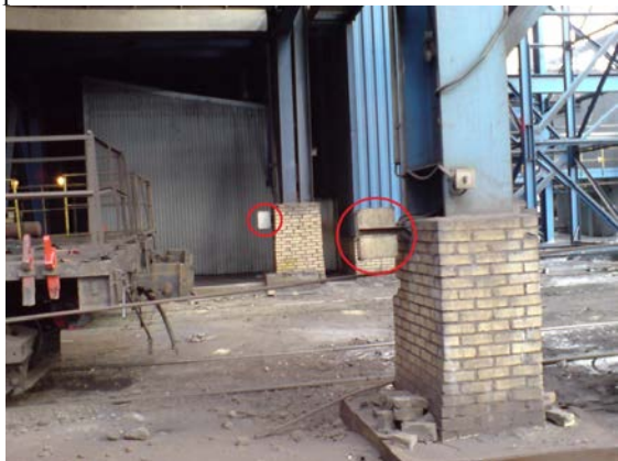
Рис. 5. Расположение RFID-считывателей на перегонах
