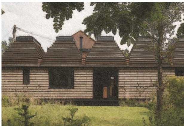
Рис. 4. Дом Cork House из сплошных блоков вспененной пробки
