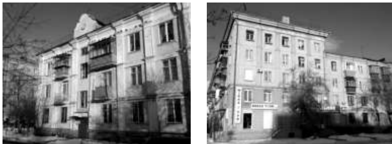
Рис. 1. Крупнопанельные жилые дома г. Магнитогорска 1950-х годов постройки
