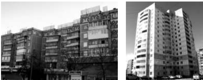
Рис. 3. Полносборные жилые дома г. Магнитогорска 80–90-х годов постройки: слева – 9-этажный дом серии 111-121; справа – 14-этажный крупноблочный дом из элементов серии 113-81
