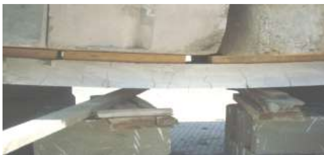
Рис. 3. Вид плиты со стеклопластиковой арматурой d 12 мм при нагрузке 104 кН
