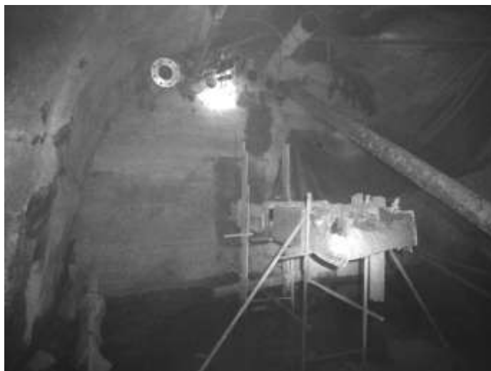
Рис. 4. Бетонная перемычка 460-4, возведенная на гор. 460 м
