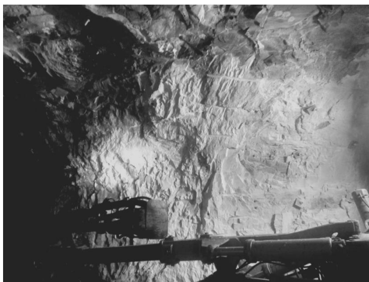
Рис. 6. Пример разметки недоборов по параметру Deviation в Сопряжении С-11
