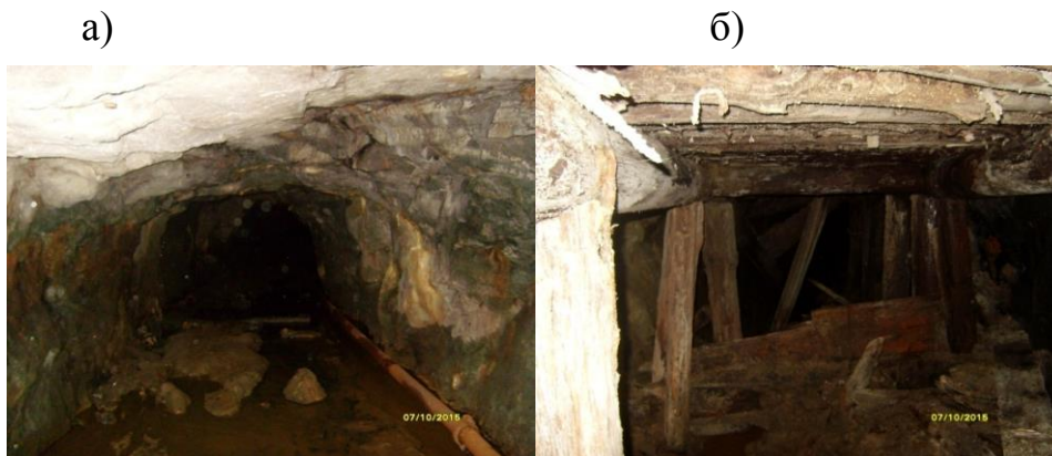
Рисунок 5.7 – Результаты комплексного обследования состояния горных выработок Кочкарского рудника: а) штрек откаточный, гор.147 м; б) очистное пространство гор.147 м
