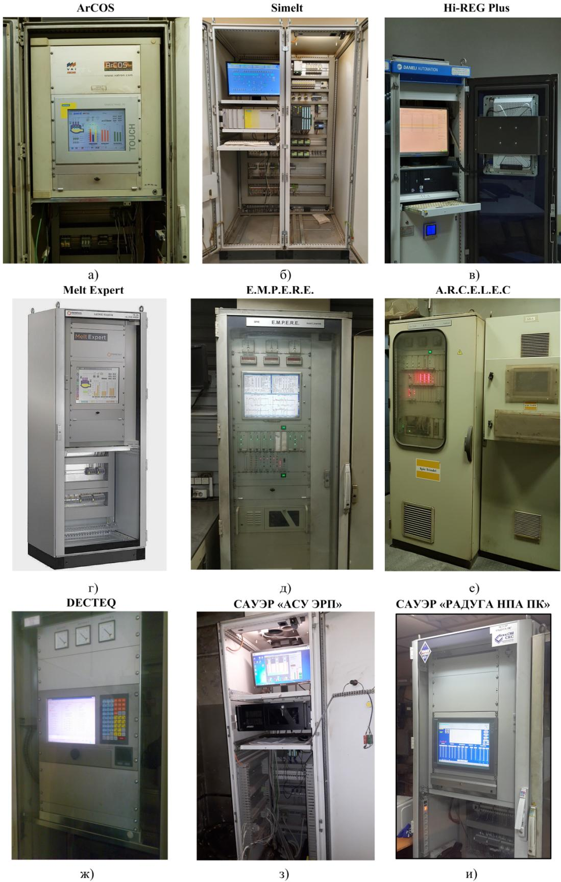
Рисунок 1.1 - Внешний вид основных шкафов с оборудованием систем автоматического управления электрическими режимами и перемещением электродов ДСП и УКП зарубежного и отечественного производства
