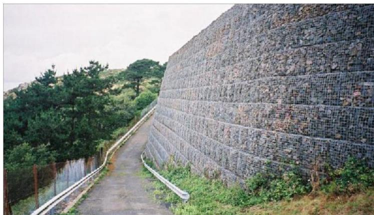
Рисунок 2.15 – Сооружение с применением габионных конструкций
