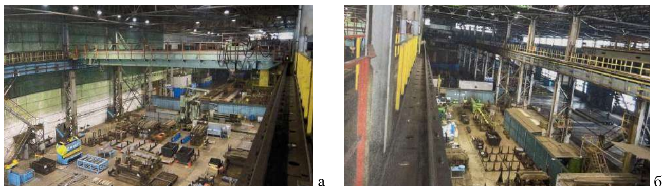
Рисунок 5.4 – Общий вид производственных помещений внутри здания главного корпуса участка гнутых профилей ЛПЦ № 8: а – общий вид пролета «К–Л»; б – общий вид пролета «Л–М»
