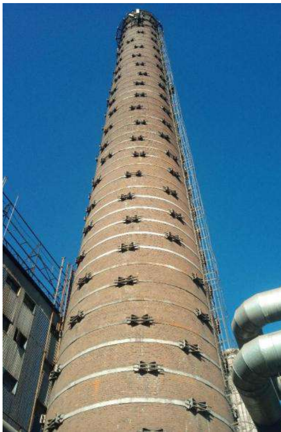
Рисунок 5.7 – Общий вид сооружения кирпичной дымовой трубы Технические характеристики объекта приведены в таблице 5.17.
